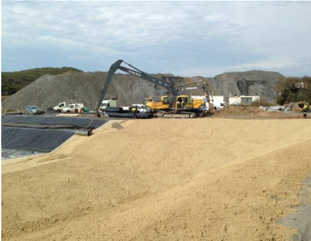
SELLADO DE CENIZAS EN LA CENTRAL GESA ENDESA. PARA LA U.T.E. URBASER / CARRERAS
