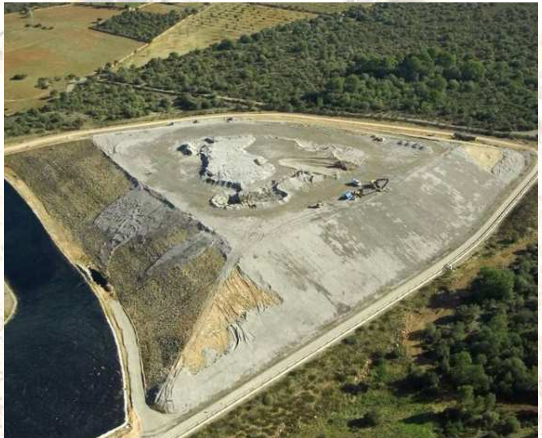
SELLADO DEL VERTEDERO DE SANTA MARGALIDA Y BALSA DE INFILTRACIÓN
