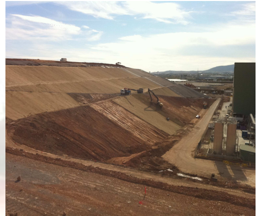
IMPERMEABILIZACIÓN DEL VERTEDERO DE SON REUS, MALLORCA
